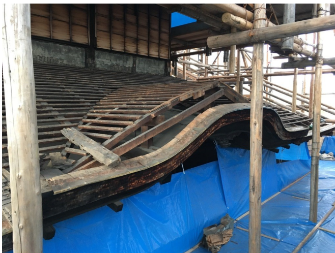
▲ 解体された屋根 (唐破風)
