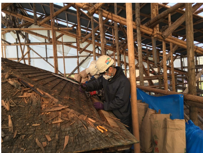
▲ こけら葺の解体作業
