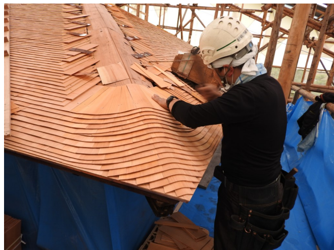
▲ 3層目屋根の隅
