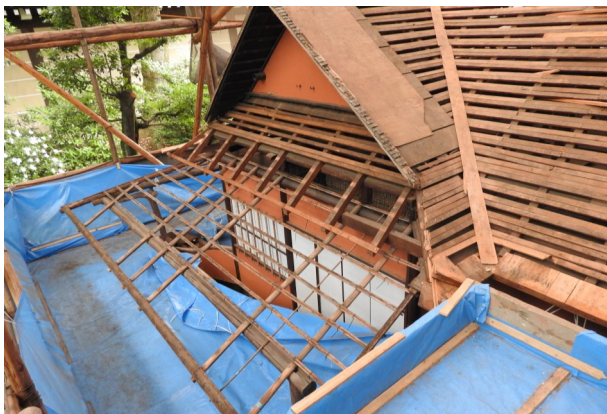
▲ 解体された憶昔屋根
