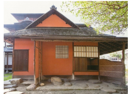
▲ 憶昔外観(修復前)
