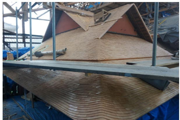
▲ 新しくこけらが葺かれた憶昔屋根
