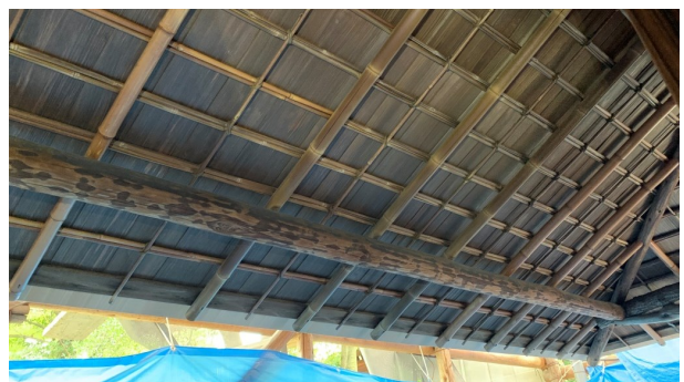
▲ 完成した庇の天井
