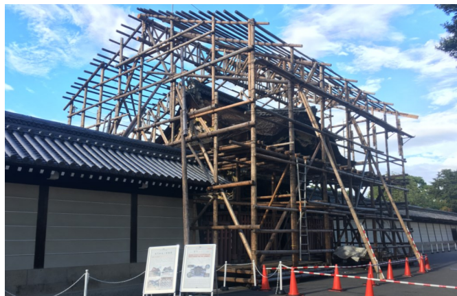
▲ 棟の上がった素屋根
