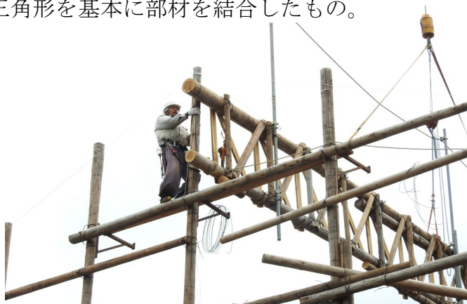
▲ 棟トラスを取り付けている様子
