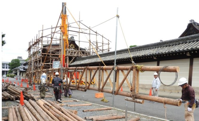
▲ 長さ約14mの棟トラス
