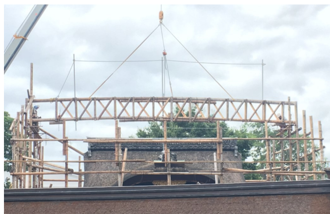
▲ 棟トラスの取り付け(正面)
