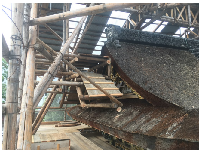
▲ 妻に設置された足場
