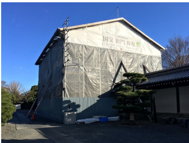
▲ 完成した素屋根
