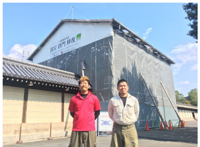
▲ 素屋根建設に携わった職人の方々（丸岡組）
