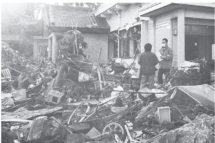
称法寺では瓦礫の撤去が進み、庫裏までの通路が確保されたことで、門徒も訪問できるようになった
