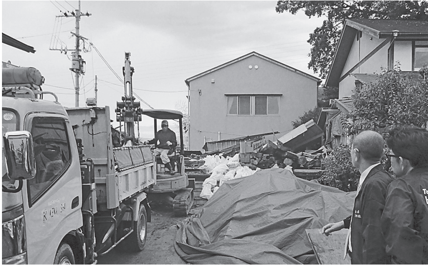
熊本市東区・光輪寺。全壊した本堂（写真中央）の解体作業を見る石上総長
