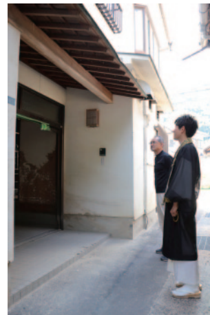
土砂を撤去しただけで 手つかずのままの庫裏
