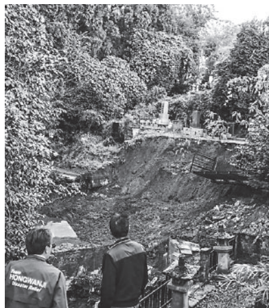
宮城県丸森町の法伝寺。裏山にある墓地が大きく崩落した
