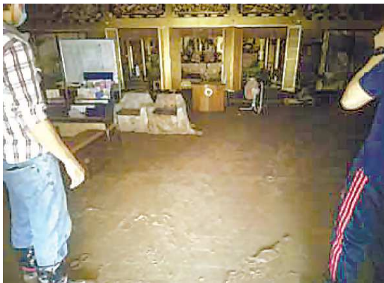
床上浸水の被害を受けた芦北町の勝延寺の本堂
