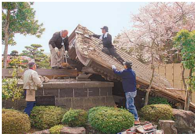
地震で倒壊した鐘楼はボランティアの手作業で解体された (撮影＝2011年4月26日)
