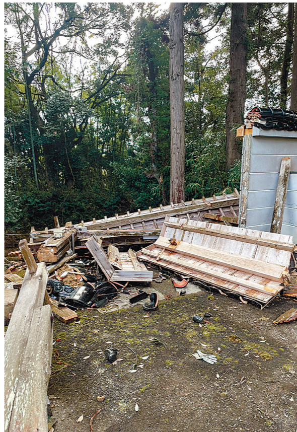
山門が倒壊した石川県能登町・松岡寺(波佐谷真充住職)。このほか庫裏の一部倒壊、内陣の仏具散乱、土壁剥離などの被害
